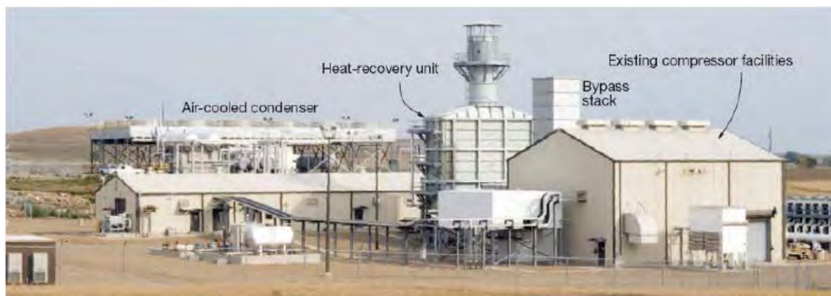
Abbildung 13: Stromerzeugung mittels ORC Prozess bei Kompressor Station Nr. 7, Northern Border Pipeline Co. (Quelle: Ormat Technologies, [Hedman 2008])
