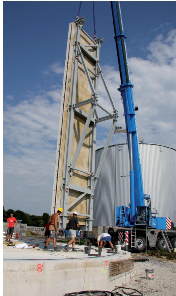
Versetzrahmen zur Montage der Wandelemente
