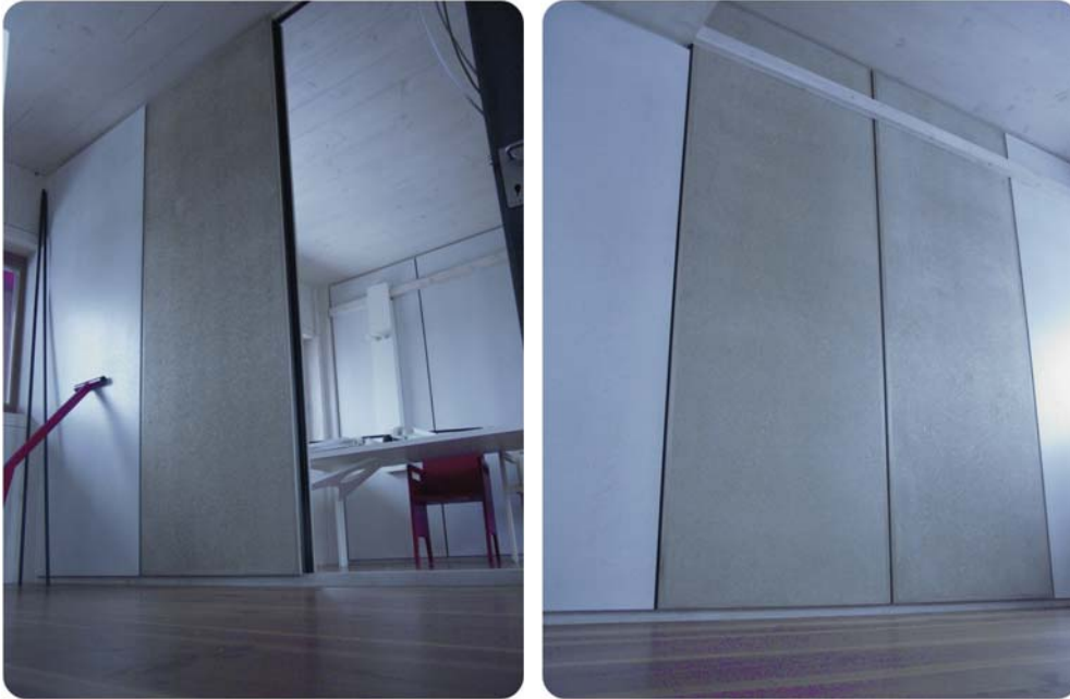
Abb.: Zwischenwand im S-HOUSE. Quelle: GrAT
