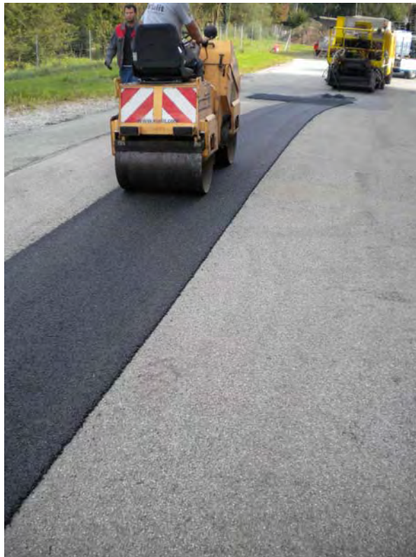
Abbildung 27: Einbaubeispiel zur Reaktivasphalt-Technologie
