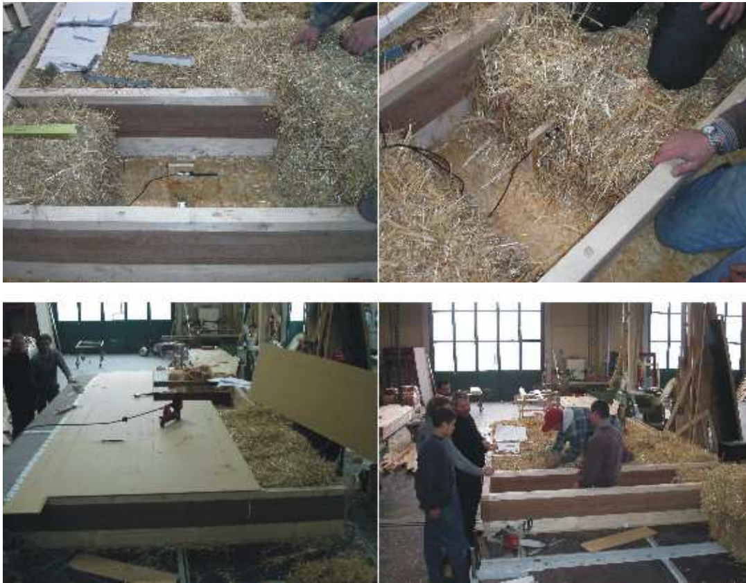
Abbildung 9: Bauteilproduktion und Einbau der Sensoren (Quelle: Holzbau Unfried GmbH.)
