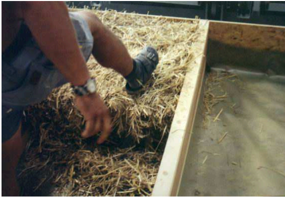
Abbildung 33: Ausstopfen eventueller Fugen mit losem Stroh (Quelle: Österreichisches Ökologie-Institut)
