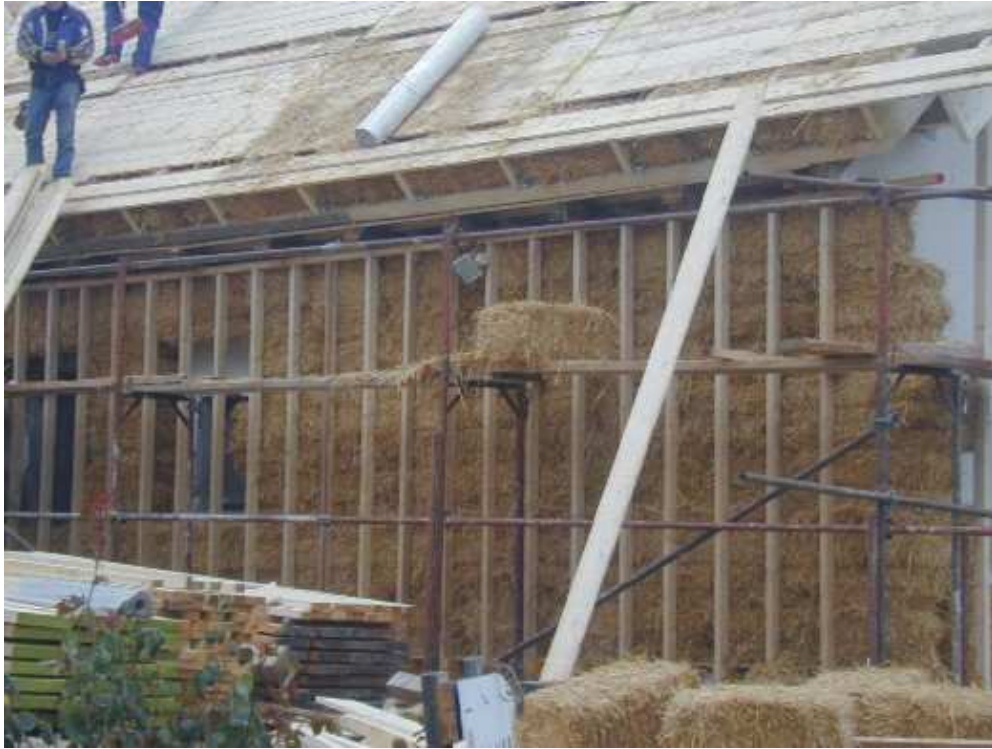
Abbildung 10: Pilotprojekt Mitterlaßnitzberg (Quelle: Haus der Baubiologie – Heribert Hegedys)
